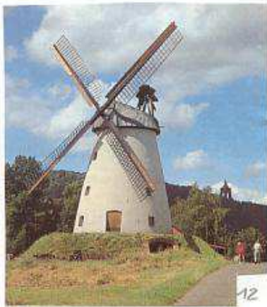
Windmühle Holzhausen a. d. Porta , auch Maschmeyers Mühle genannt. Verputzter Bruchsteinturm mit Erdwall. H./Wi. Baujahr unbekannt. Am Platz einer schon 1740 beurkundeten königlichen Wind- und Roßmühle. Vor dem 1. Weltkrieg mit Sägewerk, erst durch Dampf, dann durch Strom betrieben, wichtig als Hersteller von Kisten für Glashütte Porta. Heute zwei Elektromahlgänge. – E.: Klaus-Jürgen Kleemeier, Hackfeldstr. 56, Porta Westfalica-Holzhausen
