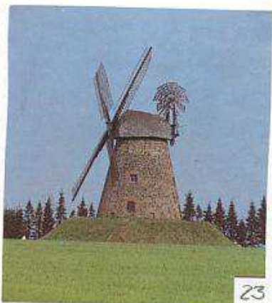
Greftmühle Nordhemmern , auch Brinkmanns Mühle genannt, von 1838. H./Wl. Konischer Turm aus grobem Porta-Sandstein mit angeschüttetem Erdwall und Durchfahrt. Kappe geschindelt. Zwei Mahlgänge vorhanden. Lt. Inschrift von 1844 früher auch Ölmühle. – E.: Günter Möhle, Windmühlenweg 65, Hille 1-Nordhemmern.
