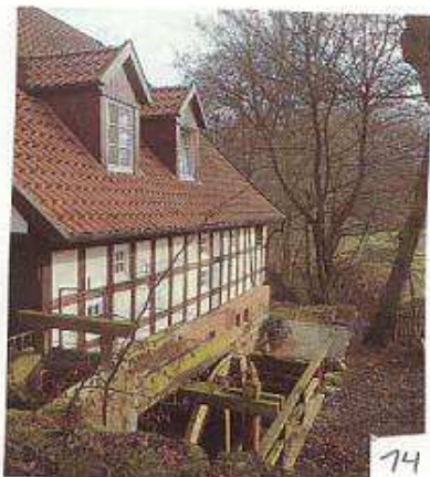
Husenmühle im Nachtigallental, Hüllhorst , 1646 urkundlich erwähnt. Früher wohl Gutsmühle des Gutes Husen, Stammsitz des Adelsgeschlechtes derer von Schloen, genannt Tribbe. Oberschlächtige Wassermühle, 2 Mahlgänge, Restaurant, täglich geöffnet, Fernruf 057 44/38 78. – E.: Erhard Held, Büttendorfer Str. 265, Hüllhorst.
