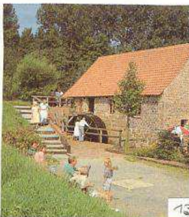
Wassermühle Bergkirchen . Alte Schönen Mühle, wahrscheinlich 18. Jh. mit oberschlächtigem Wasserrad, 2 Mahlgänge, Ölmühle. – E.: Renate Haupt und Sohn, Bartels Busch 12, Bad Oeynhausen-Bergkirchen. Besichtigung nach Vereinbarung: Fernruf 057 34/1371
