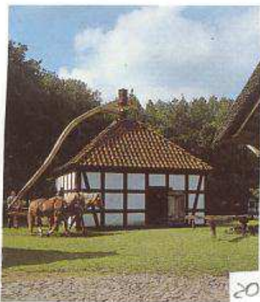
Roßmühle Rahden von 1860. Quadratischer Fachwerkbau mit kantig abgesetztem Ziegeldach. Früher in Rahden-Tonnenheide, heute im Museumshof. Antrieb durch ein Pferd, das an den Zugbaum gespannt wird, der mit der aus dem Dach hervorragenden Triebspindel fest verbunden ist. Schrot- und Bokemühle (zum Flachsbrechen) mit 4 Stampfern. – E.: Stadt Rahden – Besichtigung während der Öffnungszeiten des Museumshofes (März: 9.00–17.00 Uhr; April–September: 9.00–18.00 Uhr; Oktober: 9.00–17.00 Uhr, Montags geschlossen).
