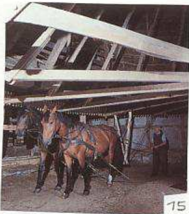
Roßmühle Oberbauerschaft von 1797. Achteckiger Fachwerkbau, über 40 m Umfang, unter rundem Strohdach, innen Göpelwerk für 6 Pferde, Kammrad von 32 m Umfang. In zwei Seitenflügeln Bokemühle und Schrotmühle. Bedeutendstes Bauwerk seiner Art in ganz Westfalen! – E.: Christoph Meyer zu Kniendorf, Oberbauerschaft 1, Hüllhorst. – Besichtigung nach Vereinbarung: Fernruf 057 41/8532
