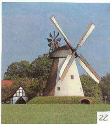
Windmühle Südhemmern von 1880 (lt. Inschrift). H./Wl. Konischer Backsteinturm mit angeschüttetem Erdwall und Durchfahrt. 2 Schrotgänge, 1 Beutengang. Ölmühle und Graupengang nicht mehr vorhanden. Mühle und Backhaus in Betrieb. – E.: Erbgemeinschaft Meier, Anfragen an Willi Riechmann, Mühlengruppe Südhemmern, Kökenweg 23, Hille-Südhemmern, Fernruf 057 03/1269 (ab 17.00 Uhr).
