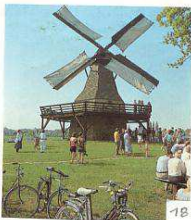
Kolthoffsche Mühle von 1922 in Lavern. früher Niedermehnen. H. Kleine eckige, taillierte Turmmühle. Verbrettertes und geschindertes Fachwerkgerüst mit Bruchsteinunterbau. Hofmahlmühle. In-Wind-Stellung mit „Stern“. Hölzerne Galerie. Auf dem Mühlenplatz alter zweistöckiger Fachwerk-Speicher und Gehäuse alter Roßmühle aus Varl. Mühle und Backhaus (auf dem Nachbarhof) in Betrieb. – E.: Gemeinde Stenwede, Stenwede 1, Besichtigung auf Anfrage, Fernruf 057 45/1090 (Verkehrsamt)
