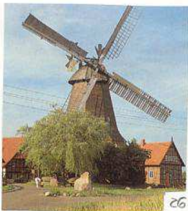
Meßlinger Mühle , etwa 1843. H./Wi. Tällierter achteckiger Turm aus Holzfachwerk auf massivem Backsteinunterbau. Verbrettert und geschindelt, mit doppelter Windrose. Hölzerne Galerie, 3 Mahlgänge und Graupengang. Fachwerkspicher als Aufenthaltsraum für Besucher. – E.: Karl-Ernst Senne, Meßlinger Mühle 1, Petershagen 1, Fernruf 05704/679
